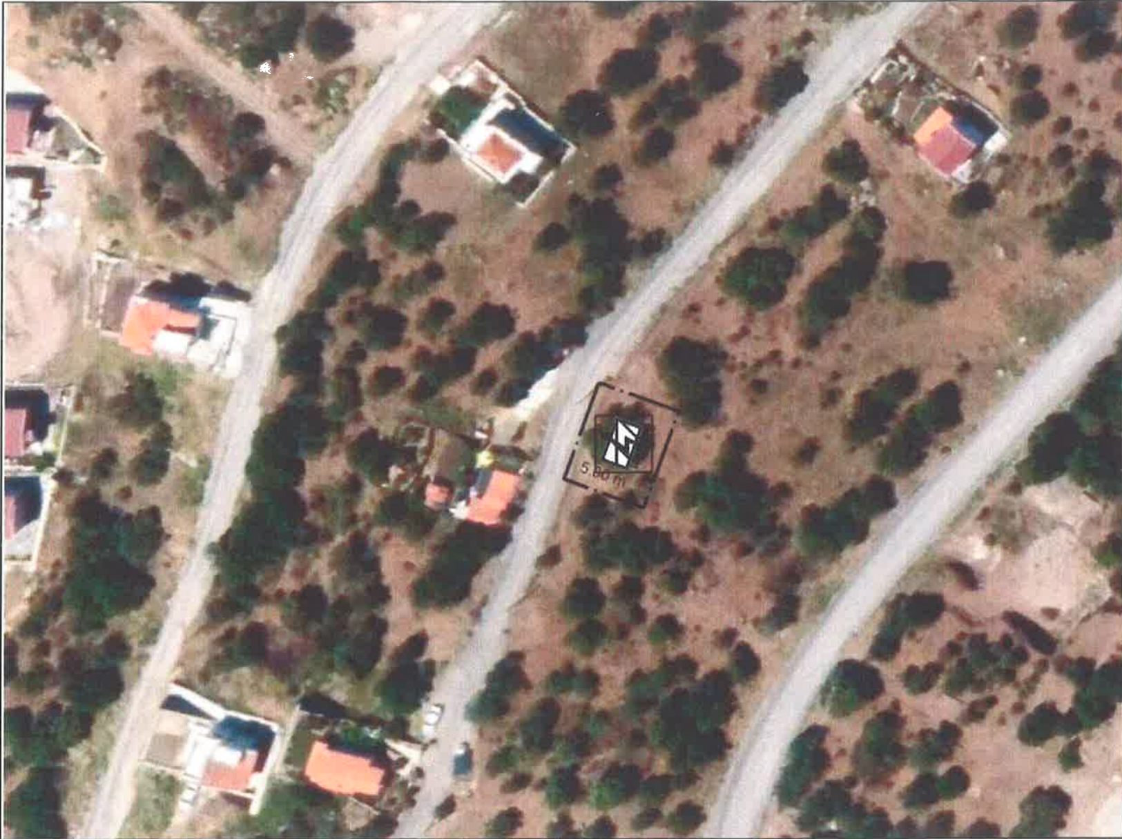
-Trafo Alanının Uydu Görüntüsündeki Konumu-
